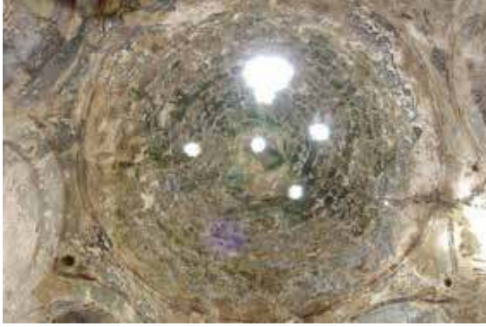
Fotoğraf 8: Beyobası Hamamı Sıcaklık Bölümü Kubbesi
