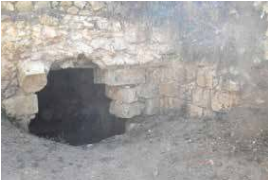
Fotoğraf 19: Sadak Köyü Hamam, halvetten sıcaklığa geçiş için kullanılan büyük, kare bir kapı. Kapı, duvarın ortasında yer almaktadır. (Ç. B. DİKMEN ve F. TORUK Arşivi )
