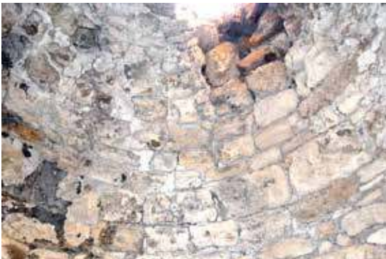
Fotoğraf 20: Sadak Köyü Hamam, sıcaklık kubbesinin iç kısmı. Kubbeye giren kemerli kapı, duvarların üst kısmında yer almaktadır. (Ç. B. DİKMEN ve F. TORUK Arşivi )
