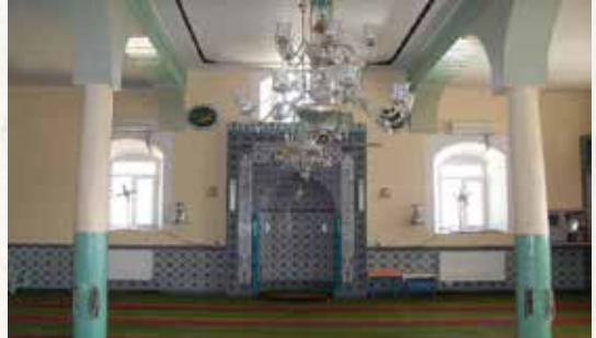
Resim 46: Kümbet Köyü Camii İç Mekan Taşıyıcıları
