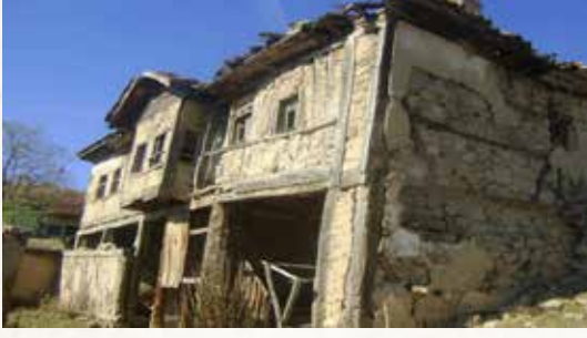
Resim 75: Kümbet Köyü, Gazi Aslan Evi, Beden Duvarları
