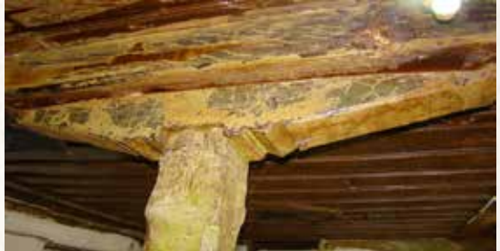
Resim 59: Kümbet Köyü, Köy Odası (İsmail Erpen Evi), Birinci Kat Odası Ahşap Strüktür
