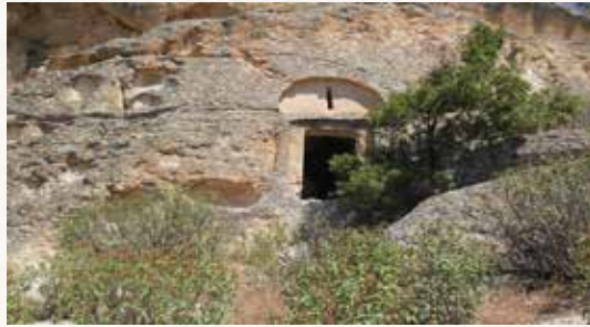
Resim 24: Kümbet Köyü Asar Kale Mevkii, Berberini Kaya Kilisesi Giriş Kapısı
