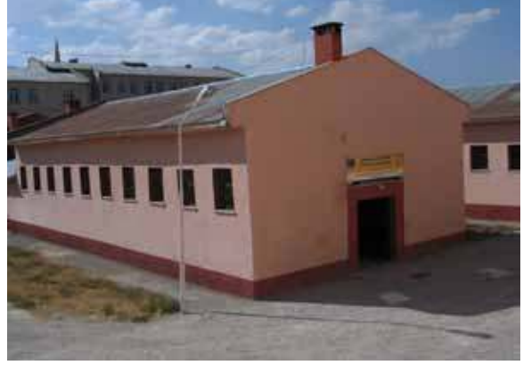
Foto 13. Eğitim atölyesi dış görünüşü.
