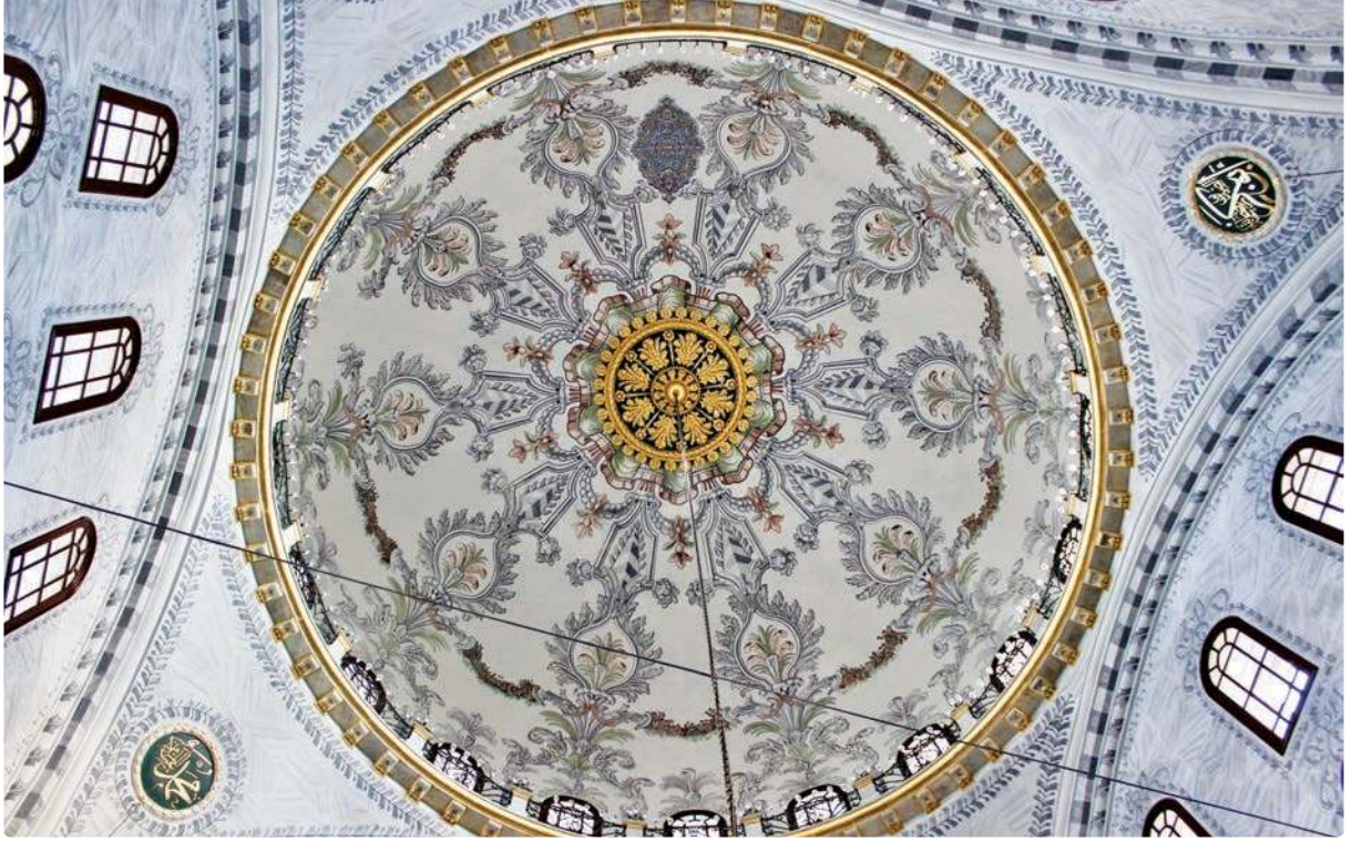
Fotoğraf 22: Nusretiye Camii kubbesi ve intikal elemanları.
