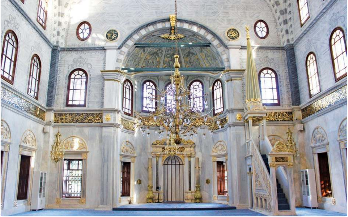
Fotoğraf 20: 2018 onarımları sonrası kalem işi programı. Mihrap duvarından görünüm.
