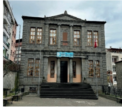
Fotoğraf 18. Mektep binasının cephesi. (Foto: N. Yazıcı, 2025).
