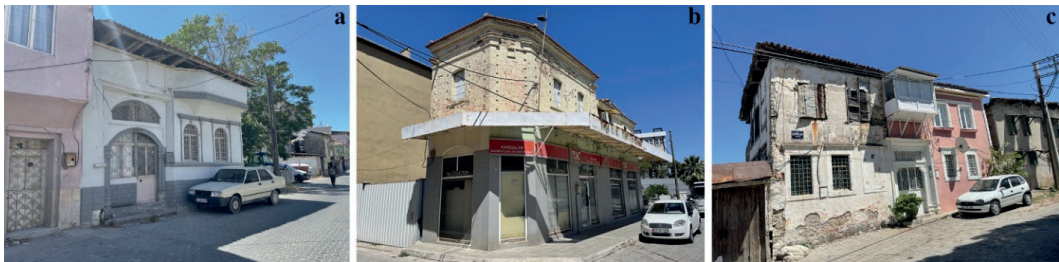
Fotoğraf 2: a) Üst katı zaman içinde yıkılmış ve onarılmamış konut örneği b) Konut cephesinde niteliksiz ek örneği c) Üst kotta yer alan balkonun PVC ile kaplandığı konut örneği
